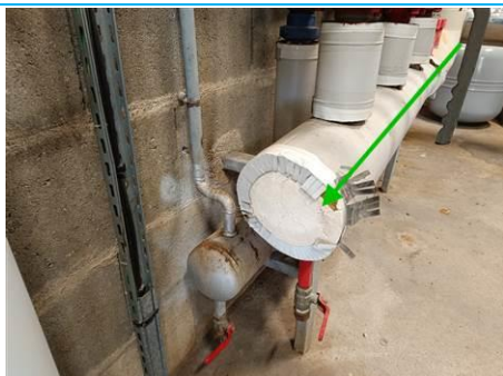
Matériaux : ZPSO-005 Prélèvement : P005 Description : Bouchon de calorifuge Localisation : RDC - Chaufferie Résultat : Absence d'amiante
