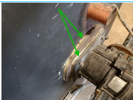
Matériaux : ZPSO-003 Prélèvement : P003 Description : Joint du brûleur Localisation : RDC - Chaufferie Résultat : Absence d'amiante
