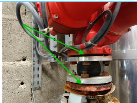
Matériaux : ZPSO-006 Prélèvement : P006 Description : Joint plat prédécoupé pour brides Localisation : RDC - Chaufferie Résultat : Absence d'amiante
