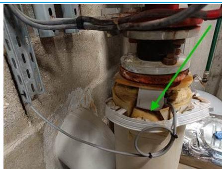
Matériaux : ZPSO-002 Prélèvement : P002 Description : Calorifuge Diam 20 cm Localisation : RDC - Chaufferie Résultat : Absence d'amiante
