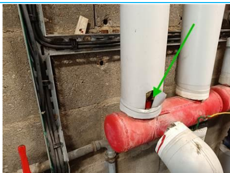
Matériaux : ZPSO-001 Prélèvement : P001 Description : Calorifuge Diam 10 cm Localisation : RDC - Chaufferie Résultat : Absence d'amiante
