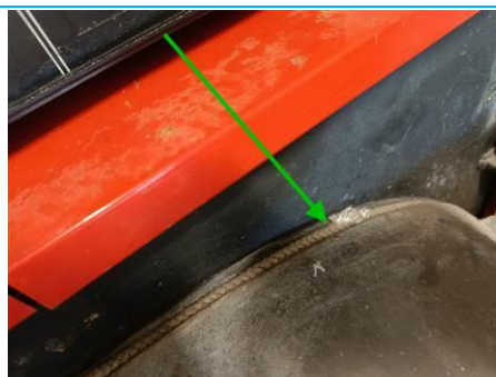
Matériaux : ZPSO-004 Prélèvement : P004 Description : Joint tresse corps de chauffe Localisation : RDC - Chaufferie Résultat : Absence d'amiante
